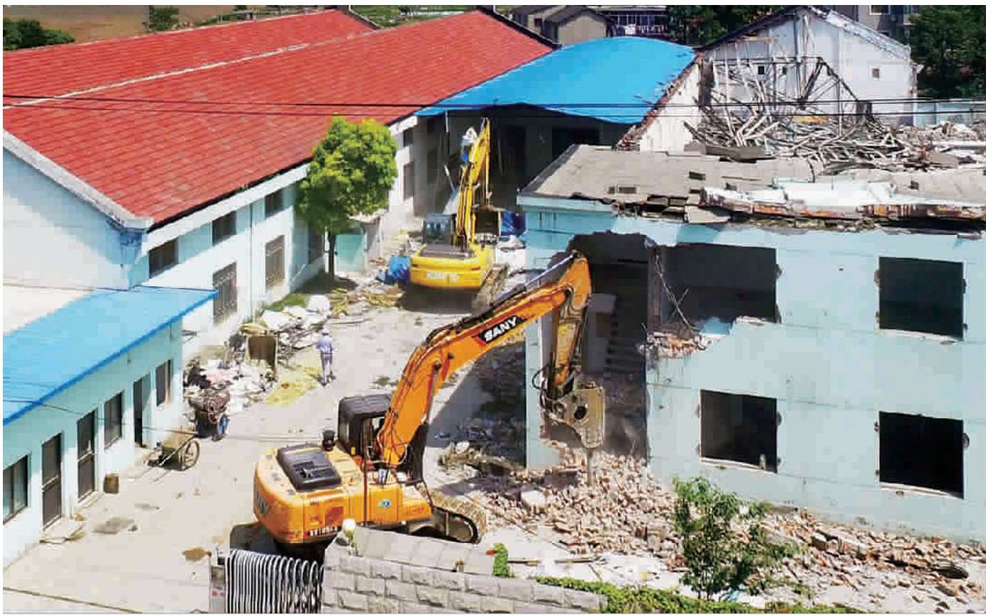
■ 今天10时,闵行区华漕镇一处违法建筑被拆除
