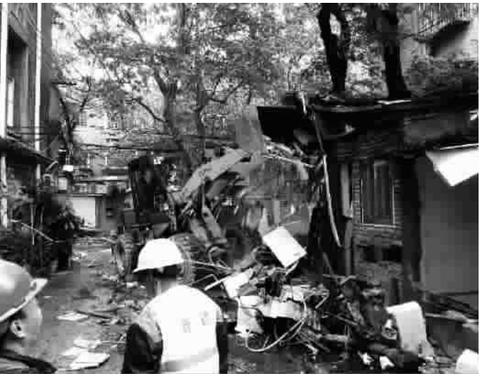
■ 安福路255号违法建筑被拆除 本报记者 陈梦泽 摄
