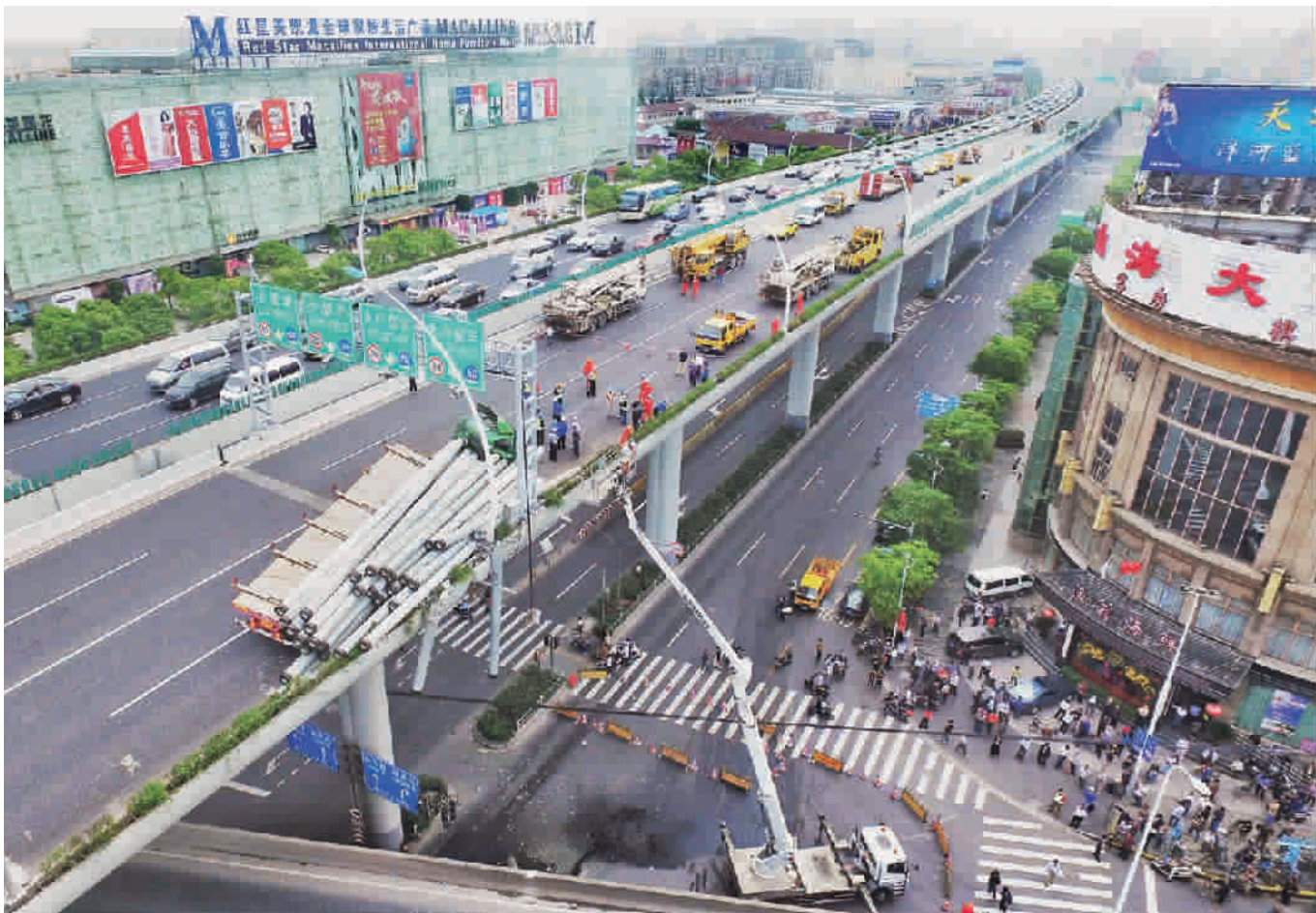
■ 今天上午, 中环事故路段交通封闭, 路政部门抓紧时间开始维修施工
