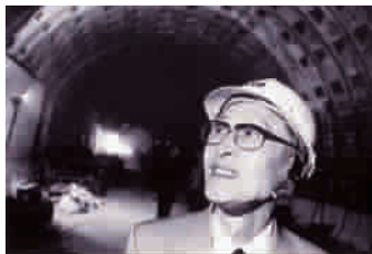
刘建航在隧道工程工地 资料照片
