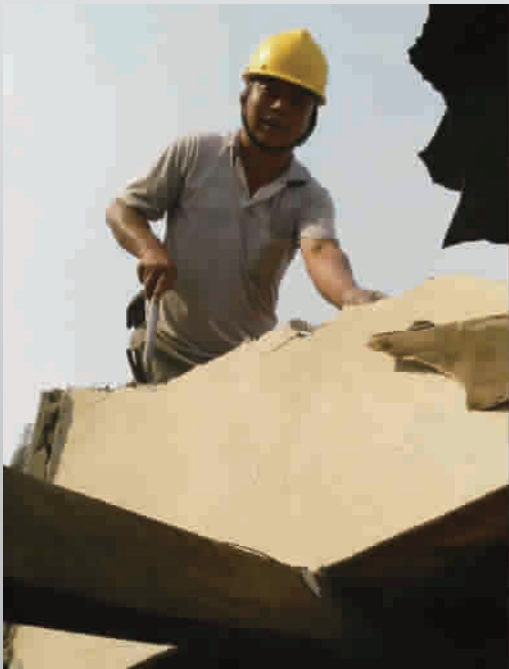
■平凉路庄女士家正在换梁修顶
