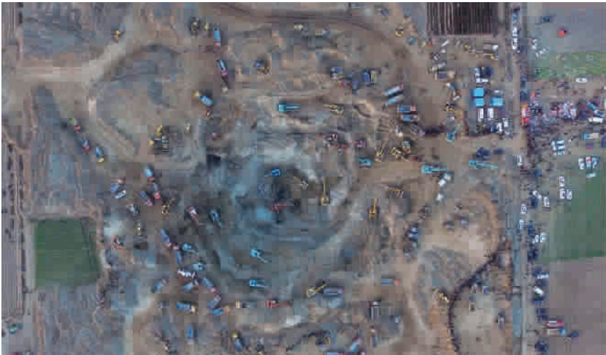
■ 上百台挖掘机在事故现场持续开展救援工作 新华社记者 王晓 摄
