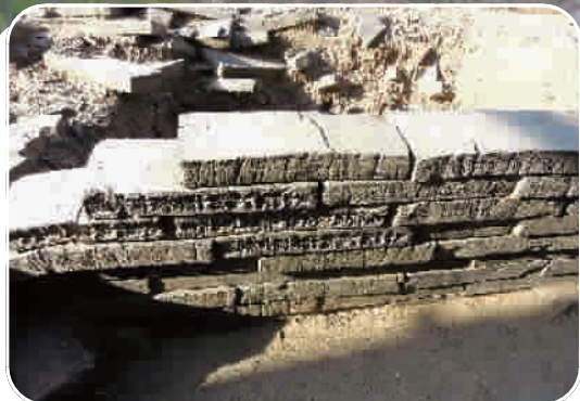
■ 隆平寺塔基出土的带有铭文的砖头 方翔 摄
