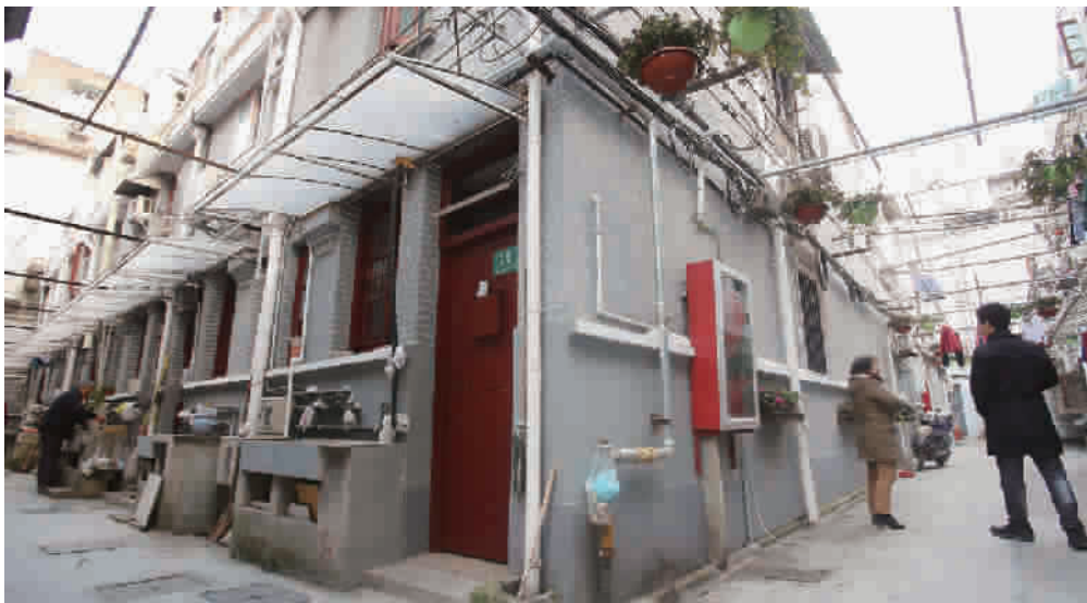
■ 佳志里修缮改造后外墙焕然一新,弄堂里吊挂起盆栽,屋外还统一安装了雨棚 本版摄影 本报记者 周轶
