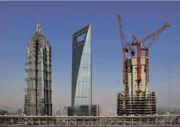
2012 年,建设中的上海中心
