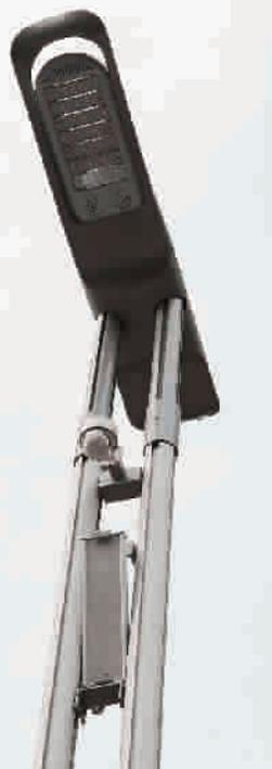
笔长短的黑色小天线。这是一种全新的单灯控制终端，依靠内置传感器捕捉路灯信息、运行状况和电流状态等，然后通过短距离高频无线通讯平台，将采集到的信息，随时报告给街口的控制箱。若遇恶劣天气，路灯周围有强信号干扰，黑色小天线就会“隐身”，路灯间的电线此时变身网线，照常传送路灯信息。
