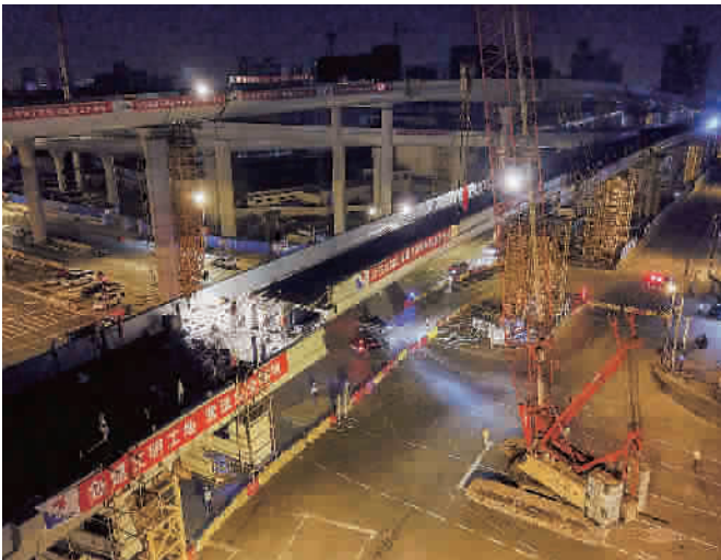
■ 最后一跨钢箱梁晨吊装完成 本报记者 陈梦泽 摄
