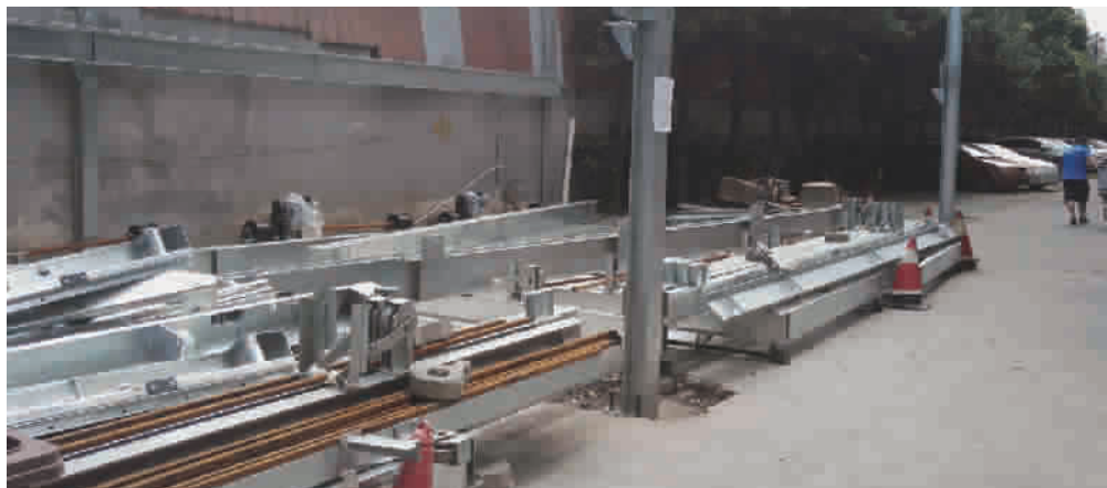
车库停工,建筑材料堆放地上
