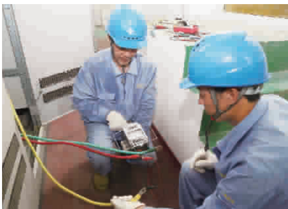
跳闸的原因 抢修人员用电表检查电线的绝缘性 本版摄影 见习记者 王凯
