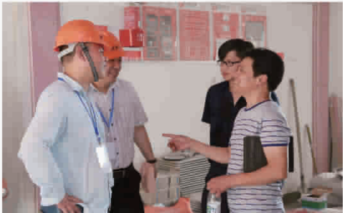
◆项目经理、集团质检、工程条线领导在40℃高温天一起来到在建工地，巡查施工质量，慰问工人情况。
