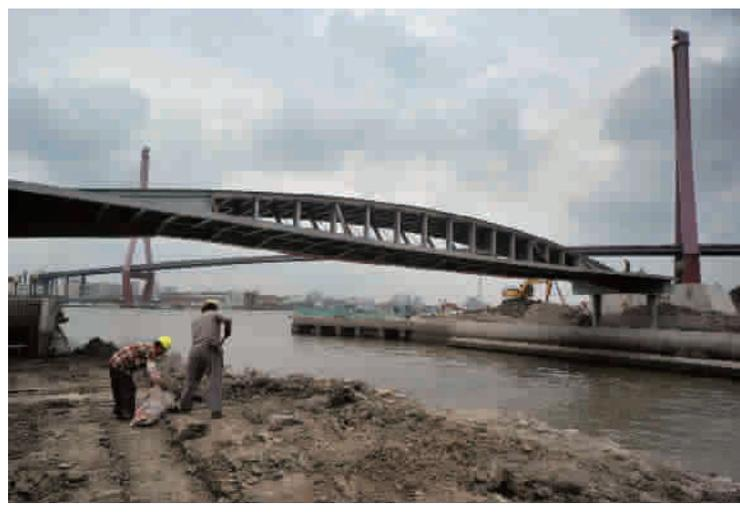
作为黄浦江东岸公共空间贯通工程的重要项目之一,12 座慢行云桥已进入全面建设阶段。位于杨浦大桥下的洋泾港云桥主体结构近日吊装就位,这座上下两层的云桥现出雏形。该桥把步行和骑行道分离,利用桥梁的桁架错位高低布置,上一层步行道的行人的视觉观感更远,可近距离观赏黄浦江景。下一层骑行道坡度减缓,方便骑行。 杨建正 摄影报道
