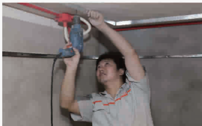
◆每一个施工节点都有严格施工标准，技术娴熟的“工匠师傅”会对每一个细节严格把控质量。
