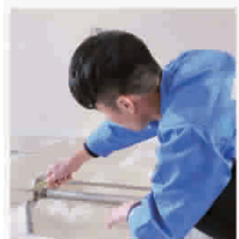
◆专业、敬业的施工师傅，对每一处工艺都力求精益求精，保证整体施工质量的高品质。
