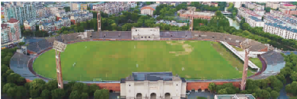
■ 江湾体育场经过整修，已重现昔日的风采，变身休闲运动中心
