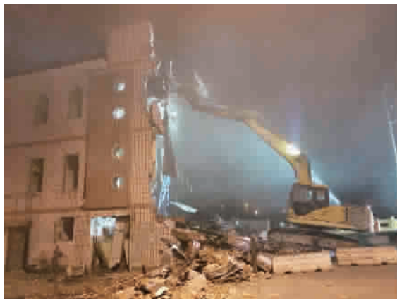
镐头机开拆房屋北侧墙面
