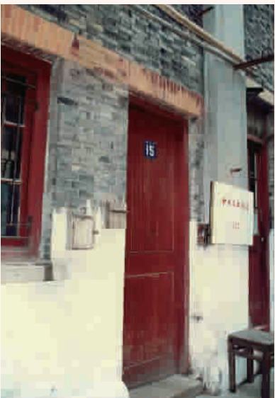
西康路中共中央文库旧址(现已拆除)
