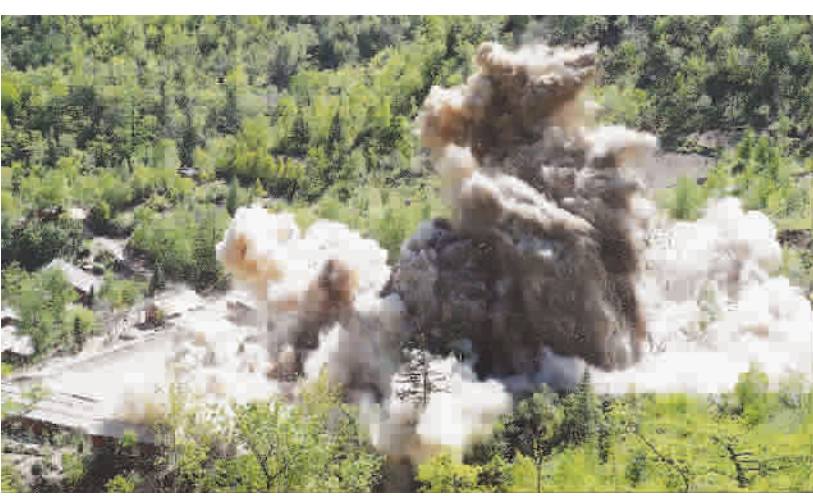
丰溪里核试验场坑道爆破场景
