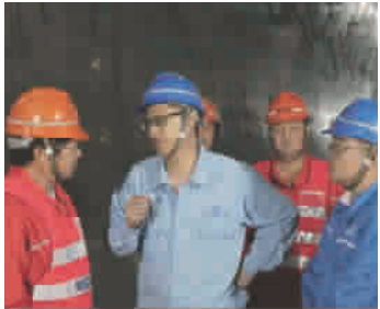
■ 李章林(左二)在隧道工地现场……
