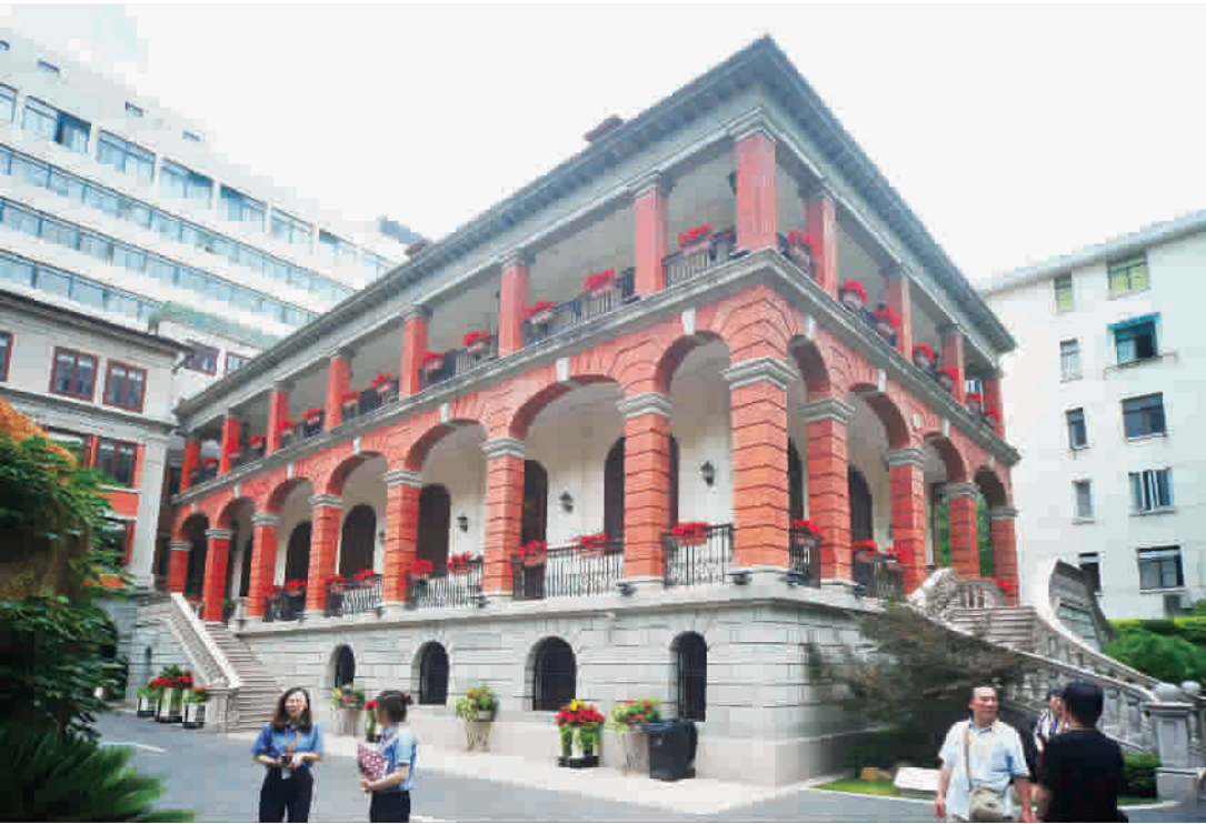
原法租界会审公廨为三层砖木结构,外置石梯,开拱形窗洞,外墙由清水红砖砌筑,气派威严。 杨建正 摄
