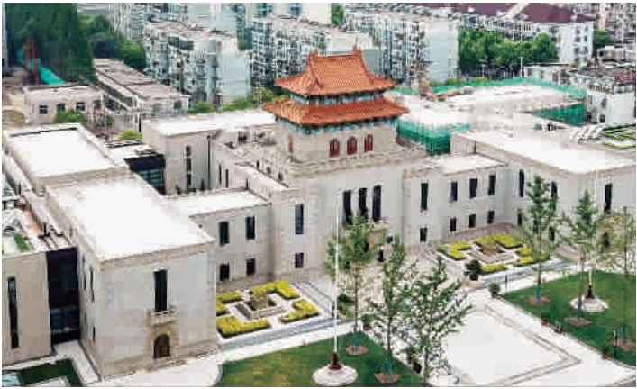
由旧上海图书馆改造而成的杨浦区图书馆正在进一步的修缮和改造中。据悉,图书馆将于年底完全开放,市民届时可一窥其风采。 李铭坤 摄
