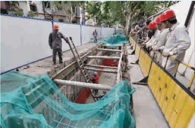
■ 工人们正为铺设地下管线做准备
