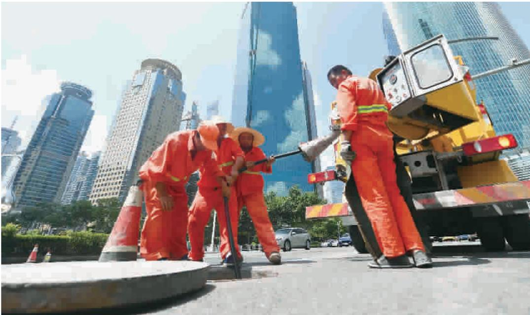
■ 昌邑路近浦东南路路口,市政养护工人正在对道路的排水管道进行清理和疏通
