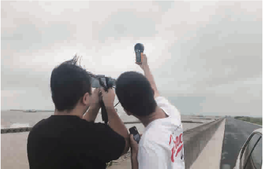
记者上午在长兴岛防汛大堤上现场测风速 本报融媒体记者 李若楠 摄
