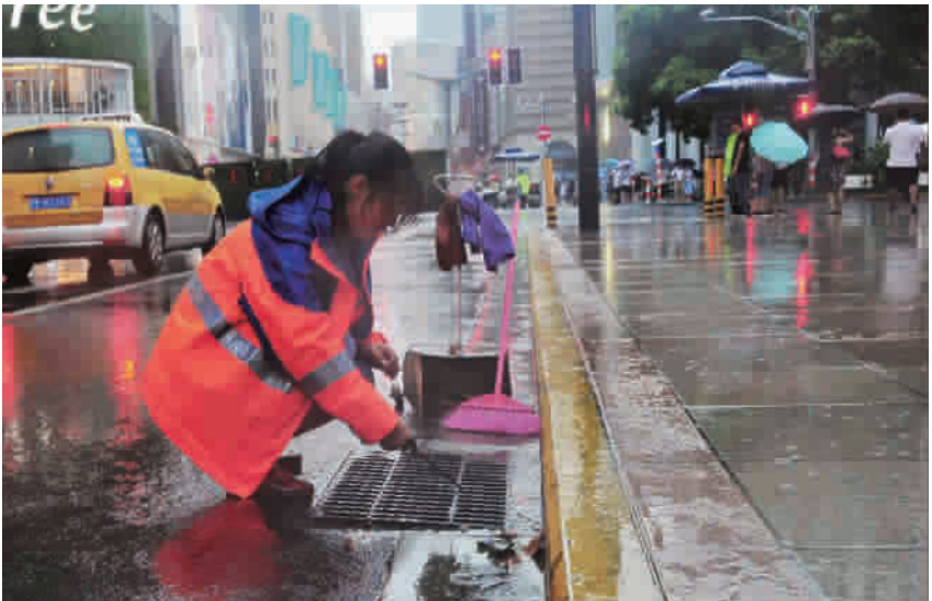
南京路步行街上,一位环卫工人在清除雨水窞井口的杂物垃圾,确保排水畅通 杨建正 摄
