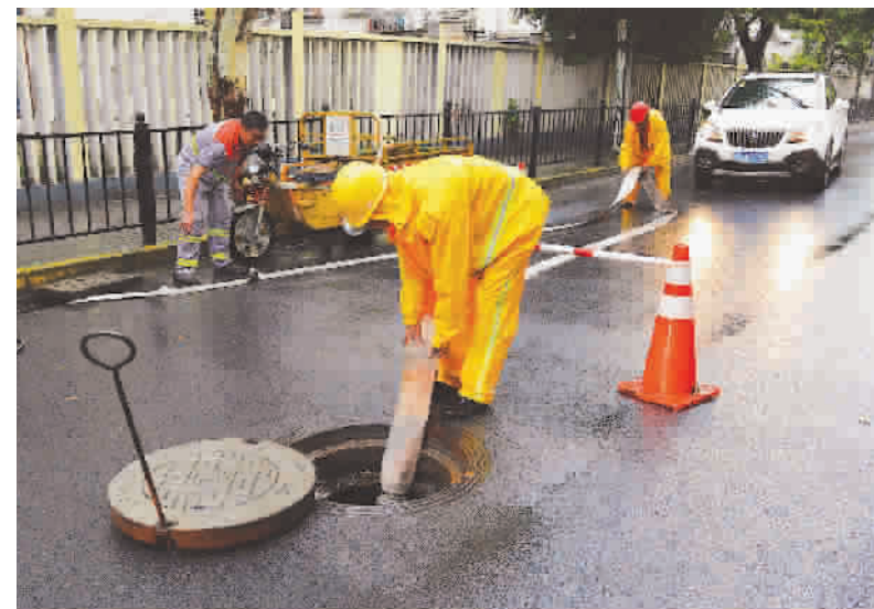
南石一路，抢险人员正在疏通雨水井，确保路面不积水 本报记者 王凯 摄
