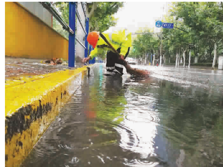
江宁路上，路政工人正在清除排水口垃圾 本报记者 孙中钦 摄
