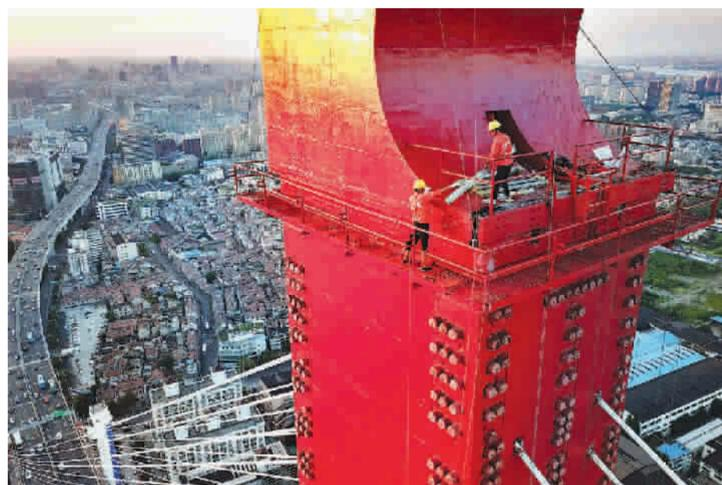
■ 2018年9月4日黄昏时分,杨浦大桥桥塔顶部景观灯光安装工程启动。8名工人用2天时间,在208米高的塔顶完成144套塔顶景观灯的安装。
