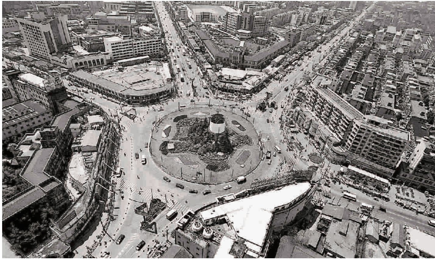
■ 1991年7月 五角场的旧貌正在悄悄改变着
