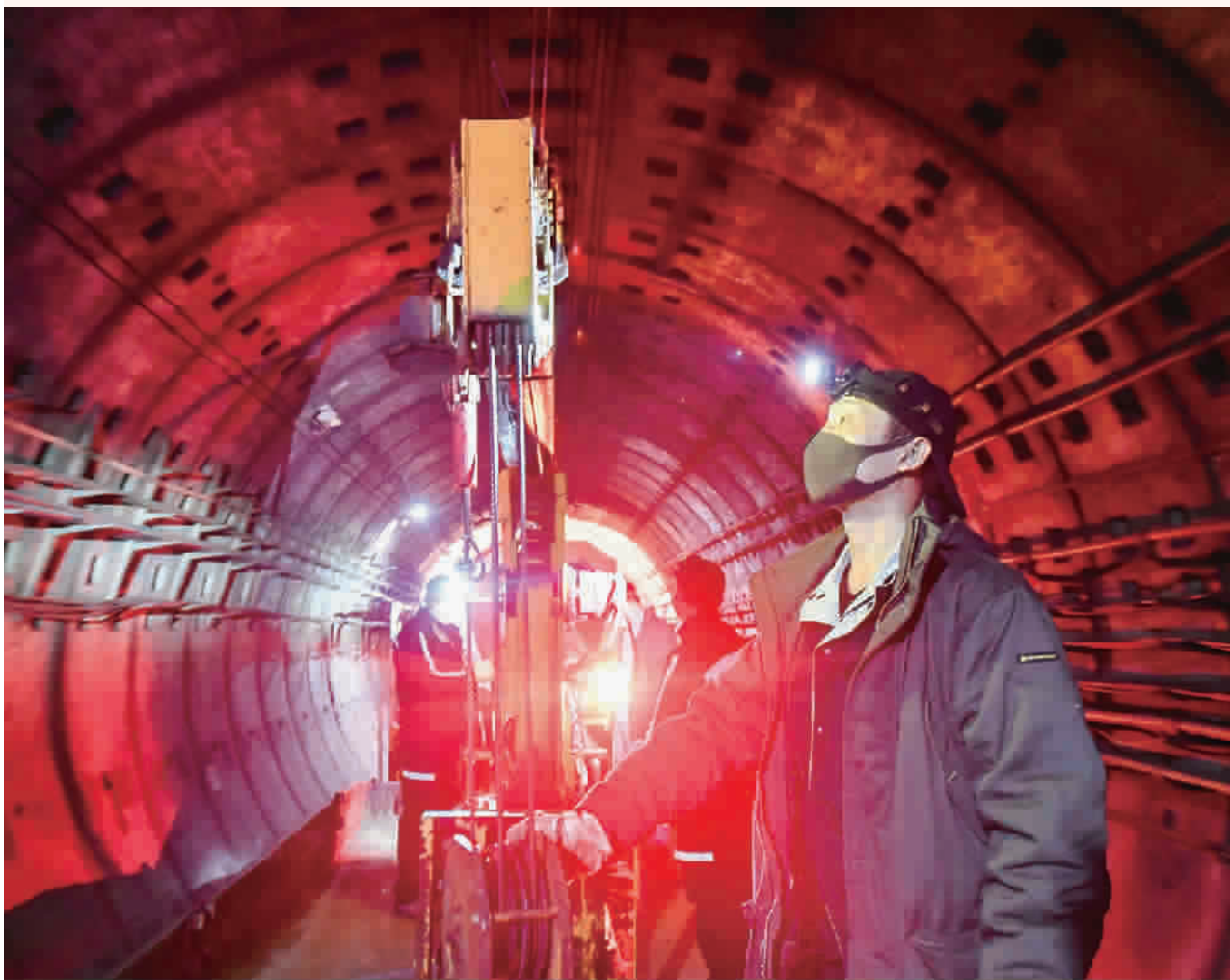
■ 刘小兵(45岁,江西上饶人,上海地铁维保工务分公司员工)今天凌晨1时在轨交1号线汉中路站进行备轨作业
