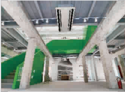
■ 新建的彩色楼梯穿插于保留的砼排架之间
