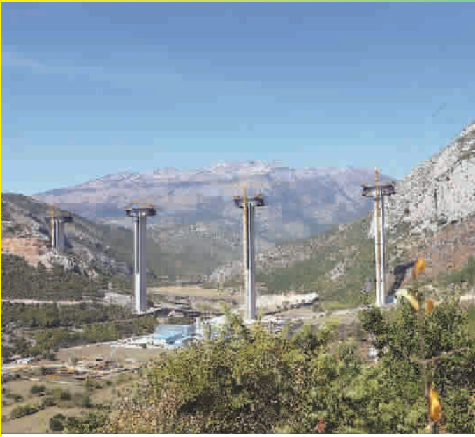
■ 这是 2018 年 9 月 22 日拍摄的南北高速公路项目第三段——斯莫科瓦茨-马泰舍沃段的莫拉查大桥施工现场。南北高速公路是黑山第一条高速公路,该段由中国公司承建
