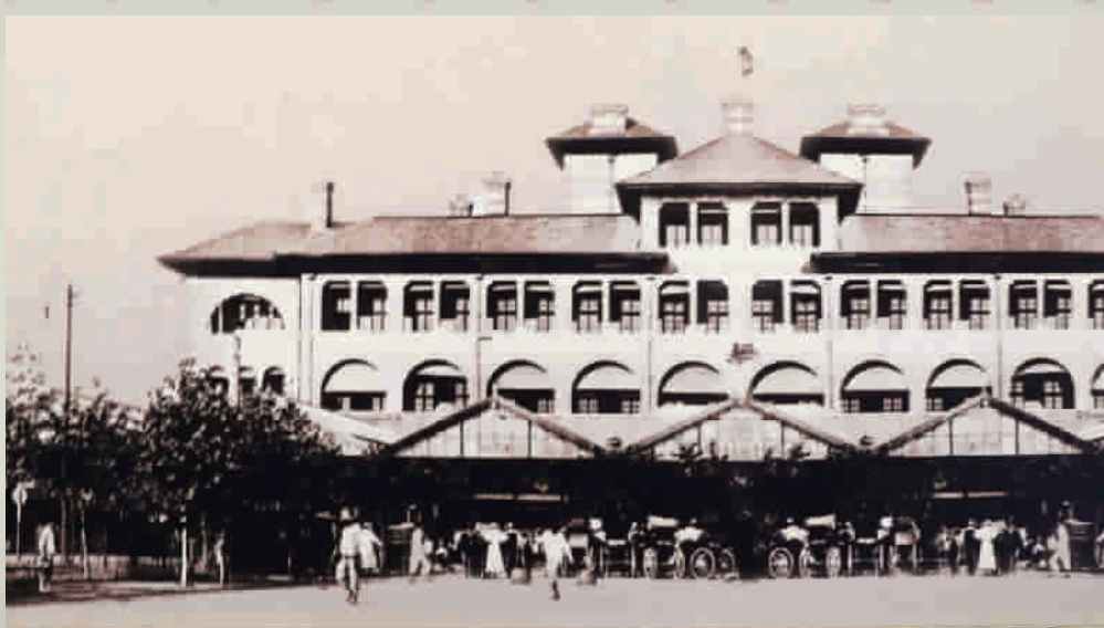
上世纪 20 年代 上海北站大楼（西立面）
