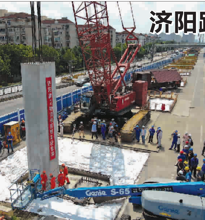
■ 济阳路快速化改建工程 2 标开启主线高架安装施工 本报记者 陈梦泽 摄
