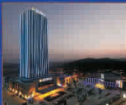
贵阳世纪金源大饭店-实景
