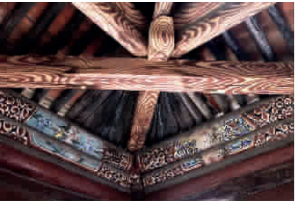
■ 全寺共有木结构殿阁四十间, 梁柱上画有精美图案
