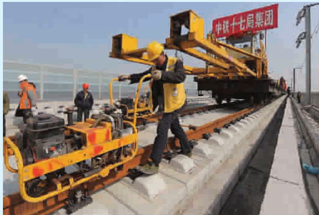
杭宁高铁 进入铺轨
