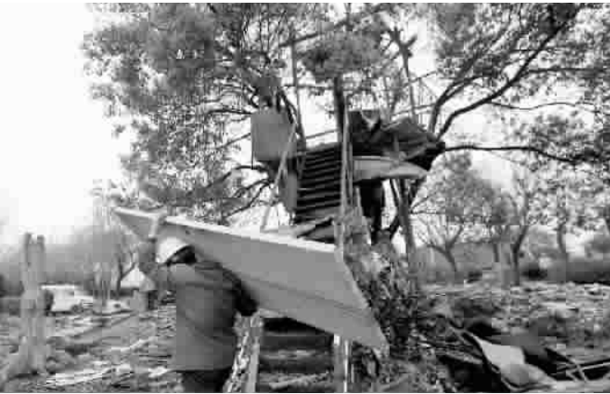
■ 工人正在拆除“树屋” 本报记者 陈意俊 摄
