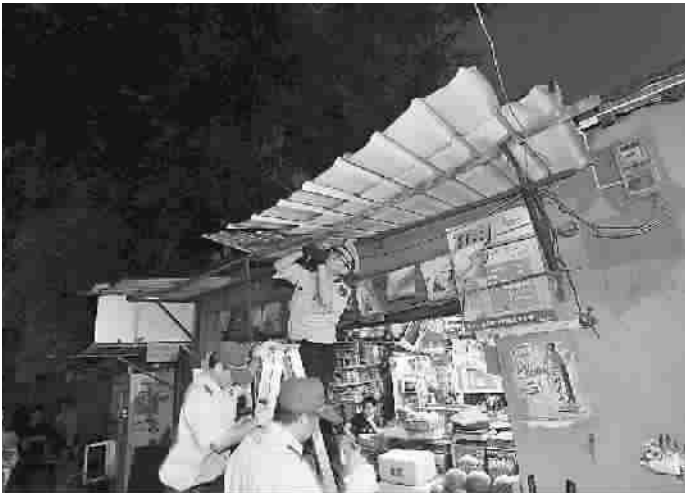
■ 违建的雨篷被拆除
