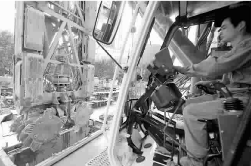
■ 一台双轮铣槽机正在施工
