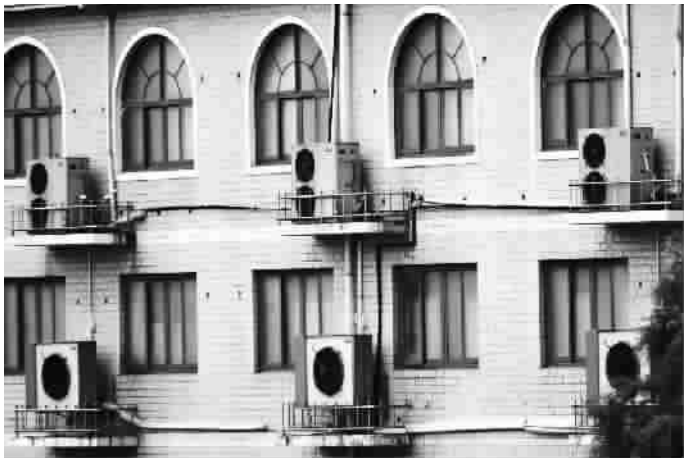
位于延安中路的一栋大楼上,空调外机配有水泥护板 本报记者 孙中钦 摄
