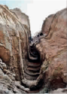
■北禅寺悬空栈道
