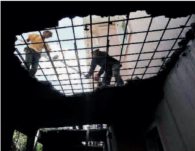
■ 工作人员正在拆除违法建筑
