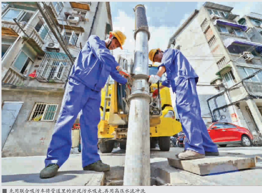
■先用联合吸污车将管道里的淤泥污水吸走,再用高压水流冲洗
