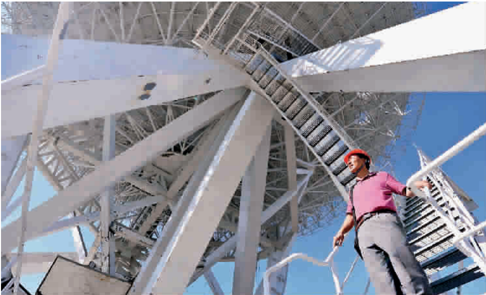
■佘山射电望远镜工地上的高级工程师凌权宝,经常要顶着烈日在工地上上下下爬几十层楼 本报记者 孙中钦 摄
