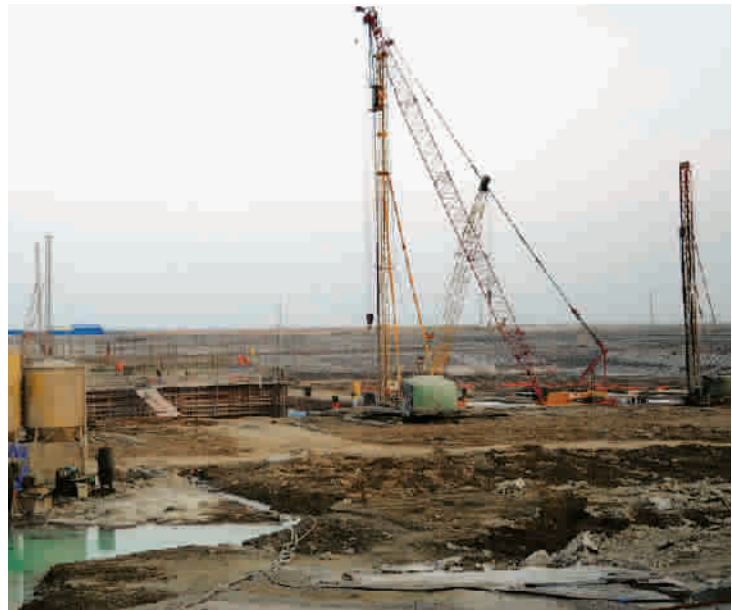
■ 2007年6月开工的青草沙工地
