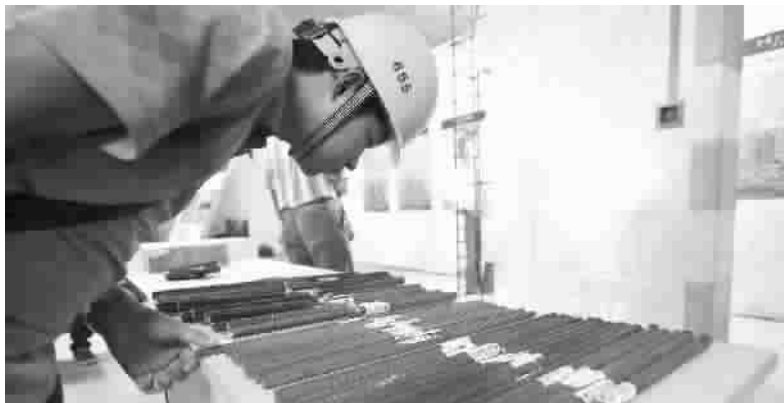
■ 上午在施工现场观摩会上,保障房建设所用工程原材料都贴有唯一性识别标识 本报记者 陈意俊 摄
