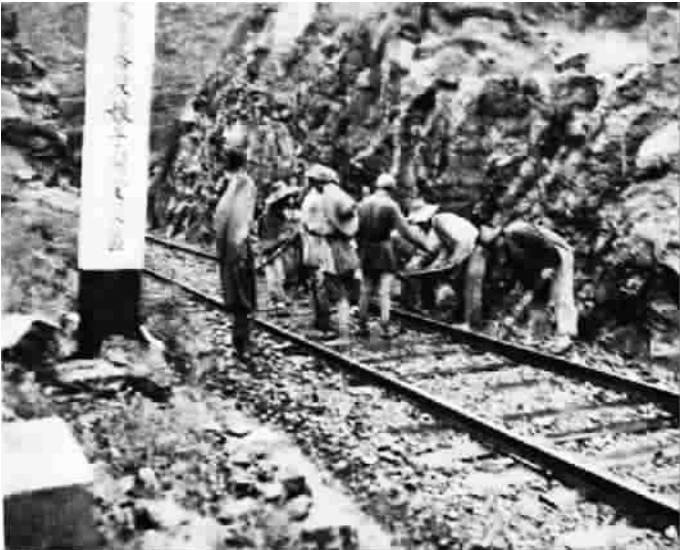
1940年9月,华北地区的八路军正在破坏正太线部分铁路
