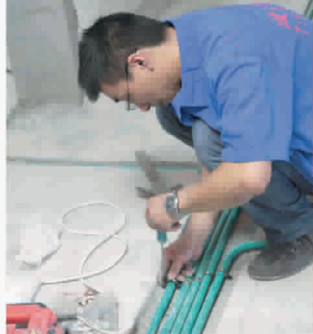
俯身地干的这位师傅，执行的是波涛自成一格的从难从严施工工艺——“所有水管、水管必须用管卡固定”，且“管卡距离为80cm，弯头处固定距离为15cm”。
