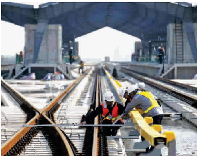
本报讯(记者 吴强)今天上午,轨道交通16号线野生动物园区域内,受电轨开始安装(如图,见习记者 陈意俊 摄)。这将成为上海地铁中首条采用接触轨受电方式的运营线路。这种方式将相对提高线路运营的抗风能力,设计时速达到120公里。地铁方面透露,16号线首列新车将于近期运抵上海,并开展一系列先期调试工作。
