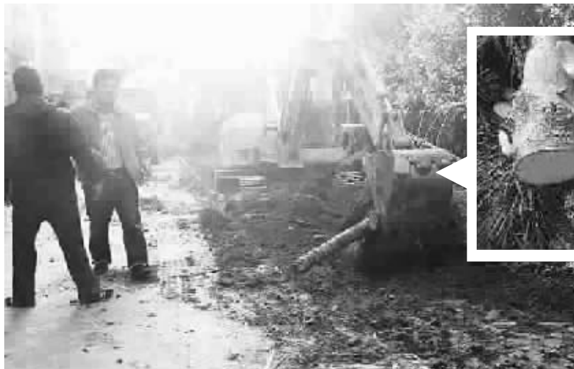
▲ 树木被砍成几段 ◀ 挖掘机正在挖掘被砍断的树干 左妍 摄
